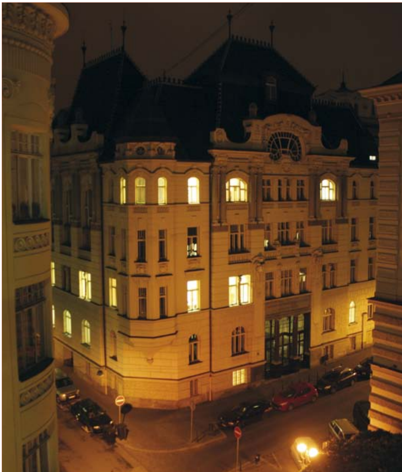
▼ The building of JAMU's Theatre Faculty at No. 1 Mozartova Street | Budova Divadelní fakulty JAMU na Mozartově ulici 1 ▼
